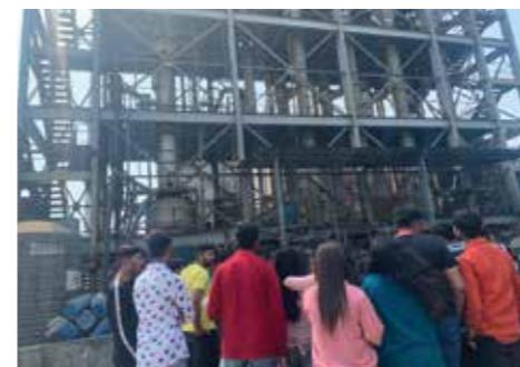
Vapi Green Enviro Limited-Cetp
